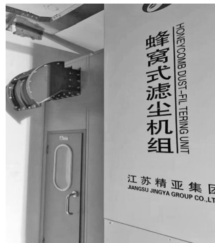
图4 蜂窝滤尘机组安装泄爆装置
